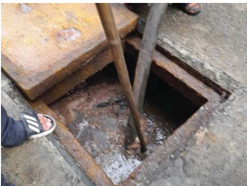
สูบลบตะกอนไขมันและ บ่อเกรอะ ของระบบบำบัดน้ำเสีย
