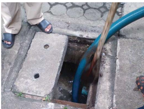
ลอกท่อระบายน้ำภายในโครงการ
