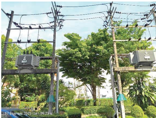
ภาพที่ 2-12 หม้อแปลงไฟ และตู้ควบคุมไฟหลักประจำอาคาร
