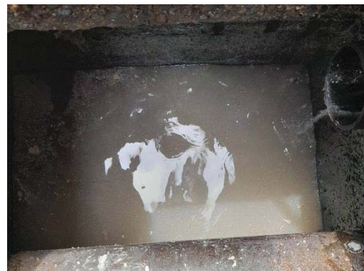
สูบลบตะกอนไขมันและ บ่อเกรอะ ของระบบบำบัดน้ำเสีย
