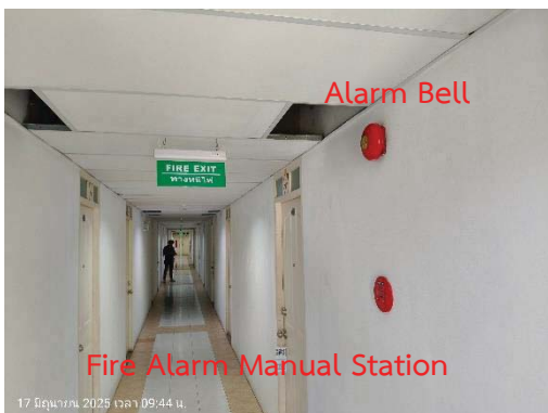
Fire Alarm Manual Station และ Alarm Bell
